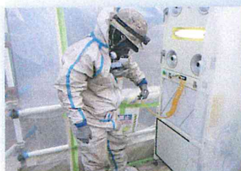
エアシャワー設置
