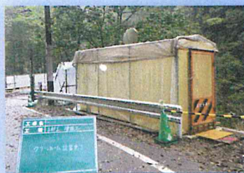
クリーンルーム設置
